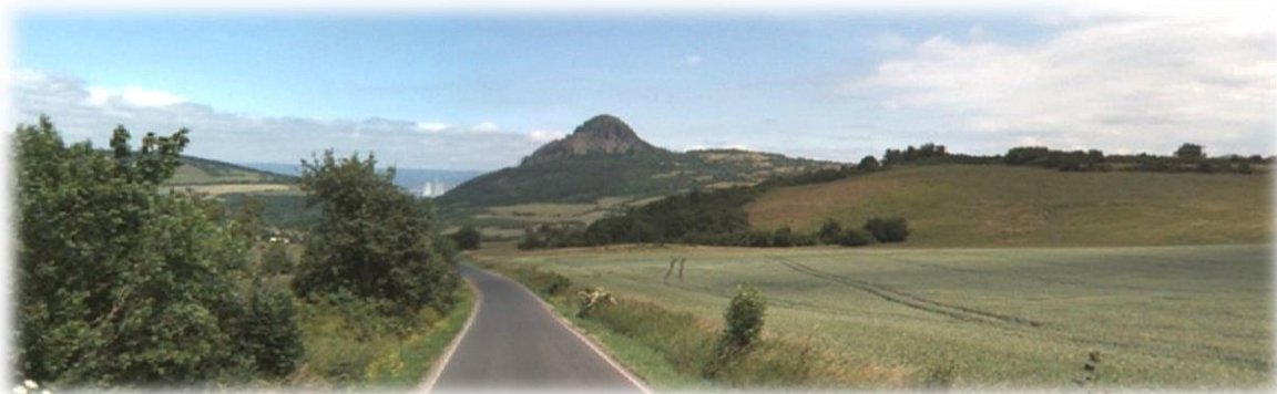
Obr: Otevření krajiny nad Svinčicemi: dominantní posice vrchu Bořeň, vzdálený horizont tvoří Krušné hory, pod nimi průhled na Unipetrol Litvínov, i přes vzdálenost cca 9 km jsou zřetelné kontury konkrétních stavebních objektů.
