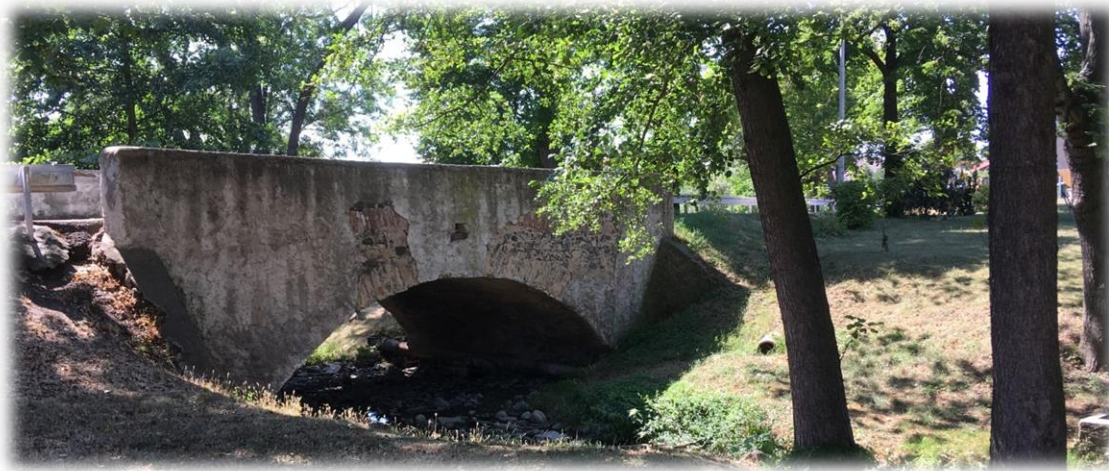
Obr: Kamenný most přes Lužický potok
